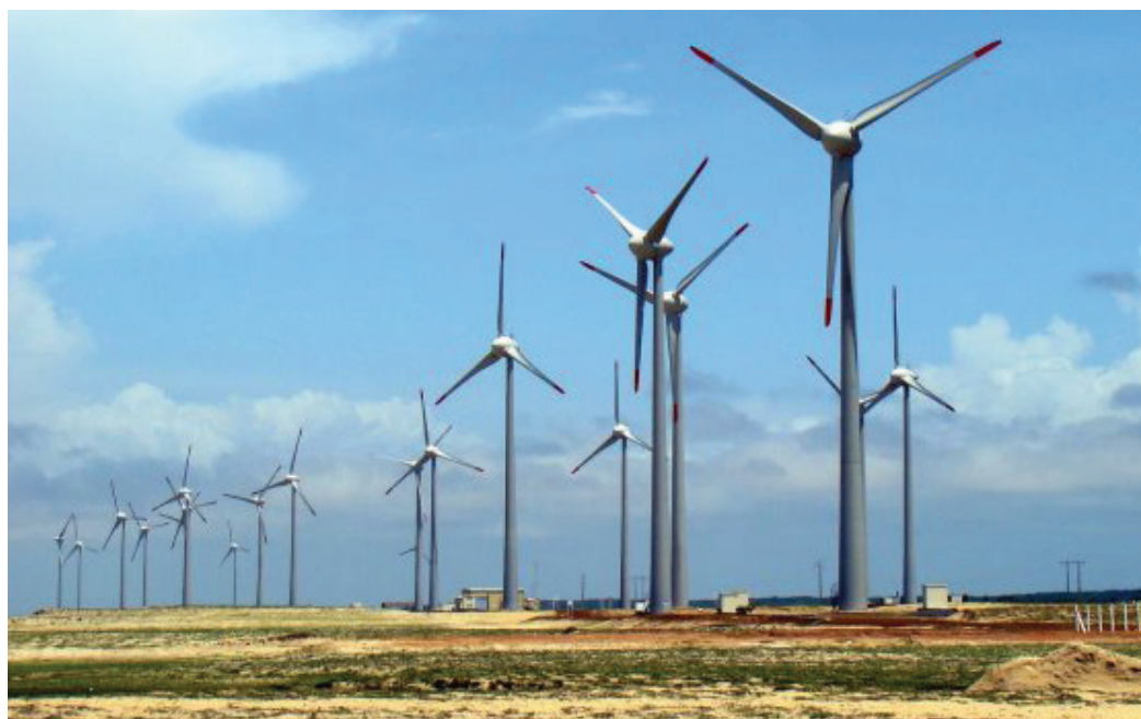
Serão pavimentados os acessos aos Parques Eólicos instalados nos municípios de Bodó, Lagoa Nova e Cerro Corá
